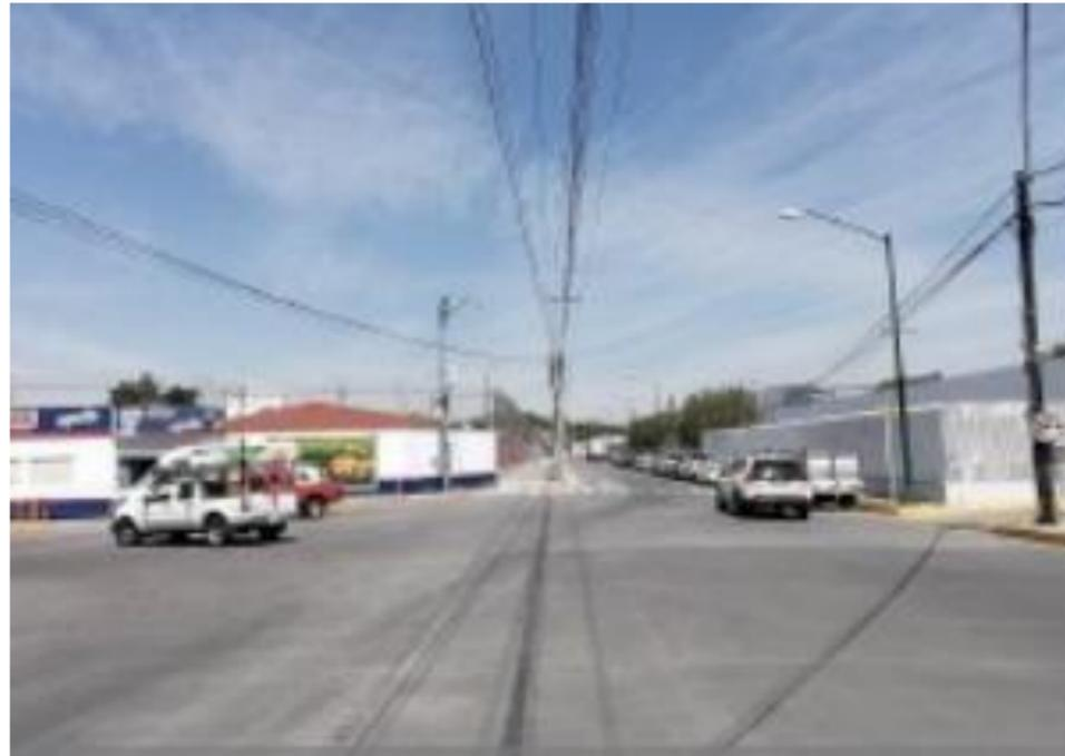
2 mil m2 de concreto hidráulico, 236 m2 de banquetas y guarniciones, 10 luminarias, señalización, cruces seguros, balizamiento y desazolve.
